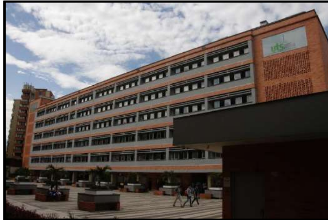
Fotografía No 3. Panorámica Edificio B
