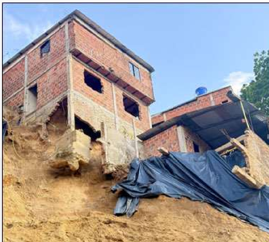
Ilustración 3. Problema de exposición de estructuras de cimentación de viviendas del Asentamiento Asomiflor
