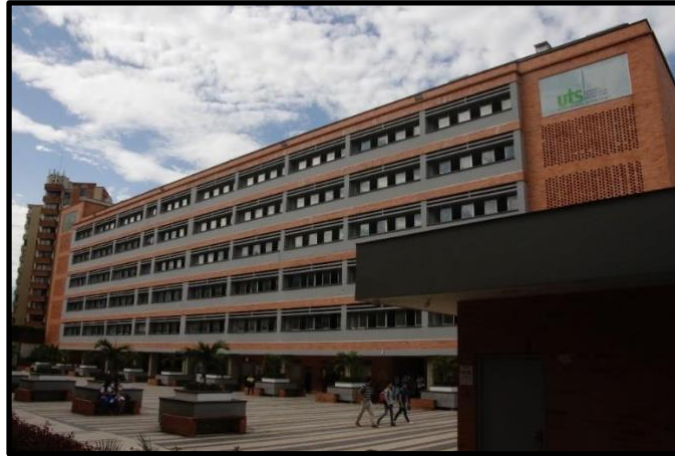
Fotografía No 3. Panorámica Edificio B
